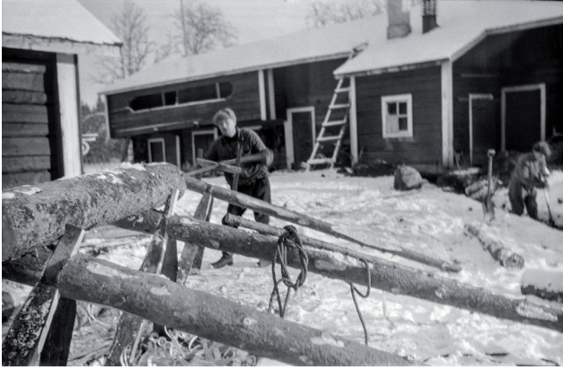
Tässä tehdään vesijohtoa "varikeittiöön". Vanha navetta näkyy vasemmalla. Oikealla näkyvä kulmaus katettiin ja rakennettiin eteiseksi, jota käytettiin aputilana ja eläinten teurastuksissa ruho vedettiin siellä "kinneriin" nylkemistä ja ym. käsittelyä varten.
