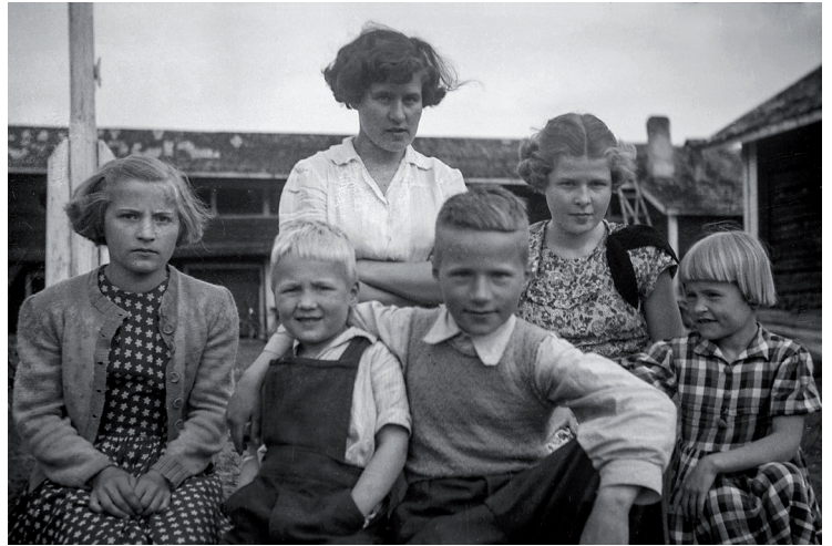
Edessä vasemmalta Armi, Matti, Jorma ja Paula, takana Leena ja Anja. Luhtirakennuksen pärekattoa on paikkailtu, uudet päreet loistavat vaaleina.
